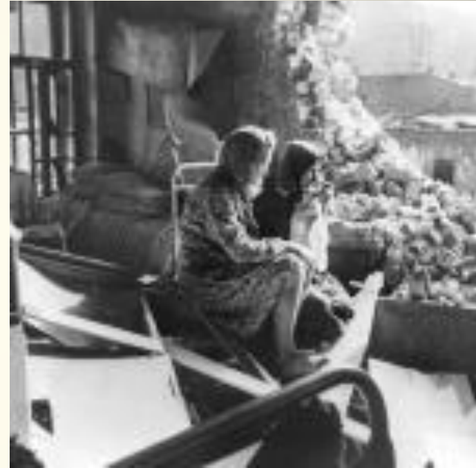
Ленинградки у разрушенного дома г. Ленинград. 1942 г.
