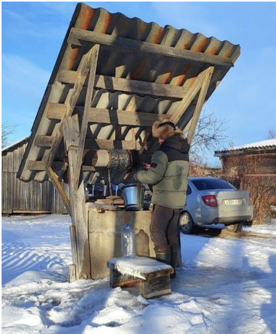
Колодец 3 (ул. Крымская)
